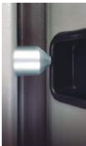
Antipalanca y junta acústica
